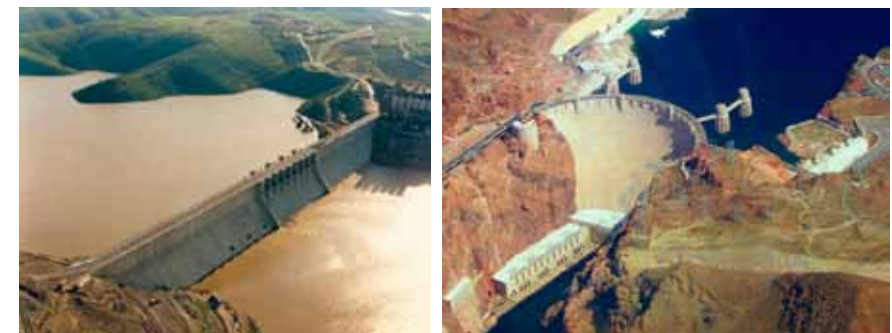
Imatges 4 i 5. El tipus de presa condiona enormement la seva percepció. A la dreta presa de gravetat del pantà de Serena a Badajoz i a l'esquerra la presa d'arc de Hoover.
